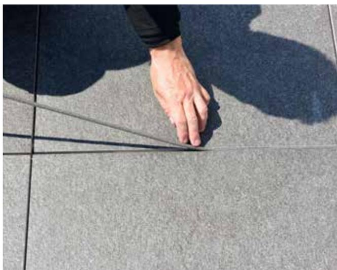
**3** Eingeplante Bewegungsfugen sind mit einer Hinterfüllschnur zur Vermeidung einer Dreiflankenhaftung zu füllen.
