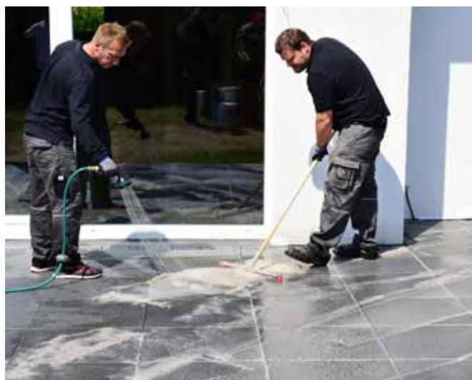
**6** Material mit dem Wassersprühstrahl befeuchten, in eine geschmeidige Konsistenz bringen...
