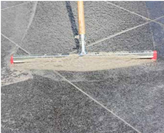
7 ... und mittels Gummischieber in die Fuge einbringen.
